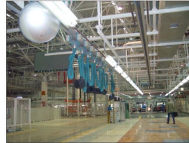
上海大众二厂 （半自动滑轨式软管尾气抽排系统） SVW CP2 ( Half-Automatic oval System with conveyor)
