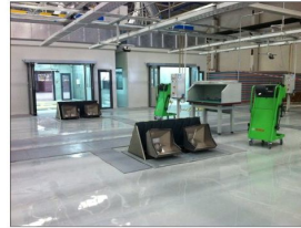
上海大众三厂（半自动滑轨式软管尾气抽排系统） SVW CP3 ( Half-Automatic oval System with conveyor)
